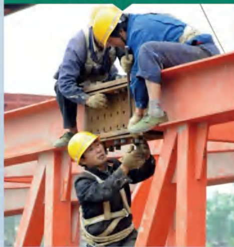
桥梁 / 道路维修加固
